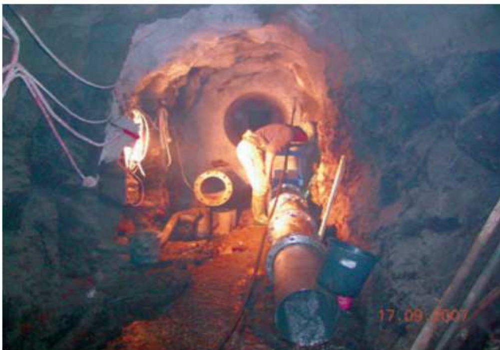
Die Herrichtung des Dammbauwerkes in ca. 230 m Stollentiefe. Es soll nun die schadlose Ableitung des anfallenden Grundwassers gewährleisten.
