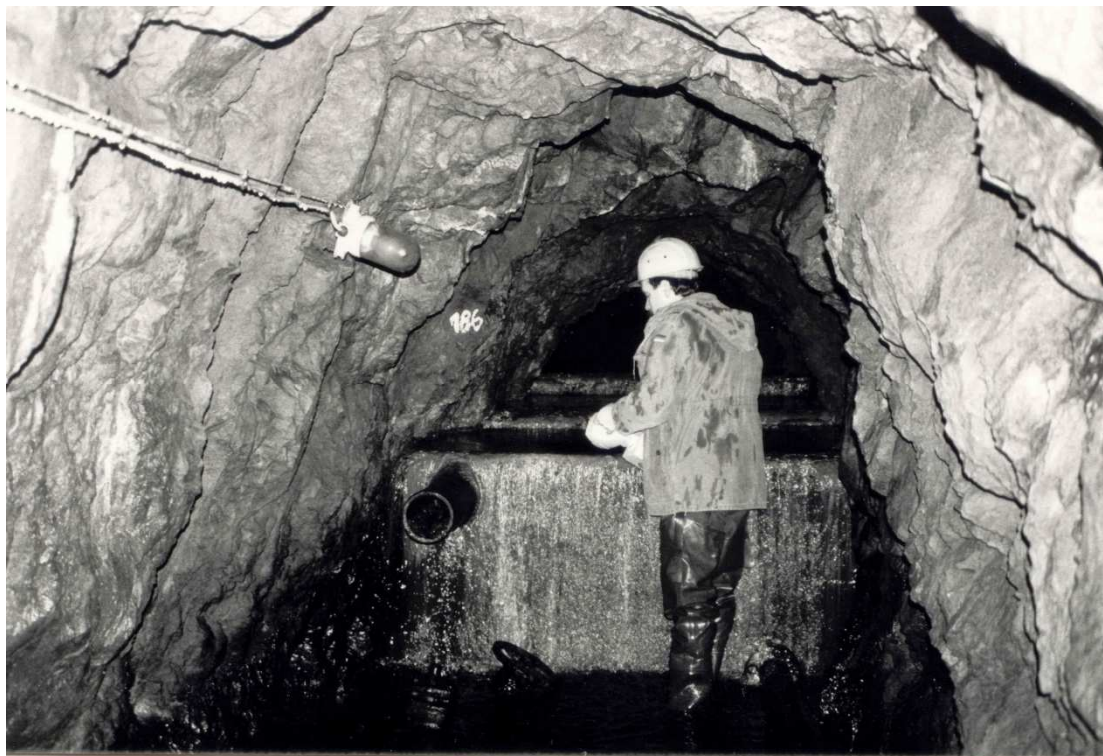
Arbeiter an den Staumauern in der Grube Magdalena Bild entnommen aus dem Archiv der Gemeinde Morsbach
