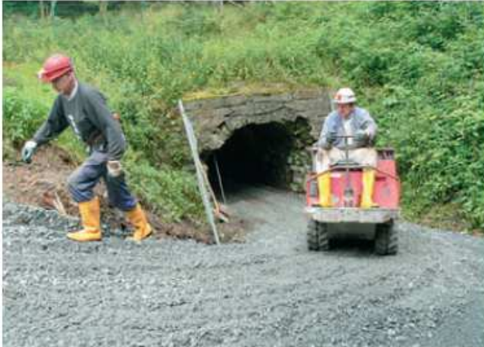
Im Laufe des Jahres 2007 konnte schließlich die Grube Magdalena in etwa 230 m Stollentiefe mit einem Dammbauwerk gesichert werden. Das Foto zeigt die Arbeiter einer Bergbau-Spezialfirma am Eingang des Stollens, die die Materialien unter Tage befördern mußten.
