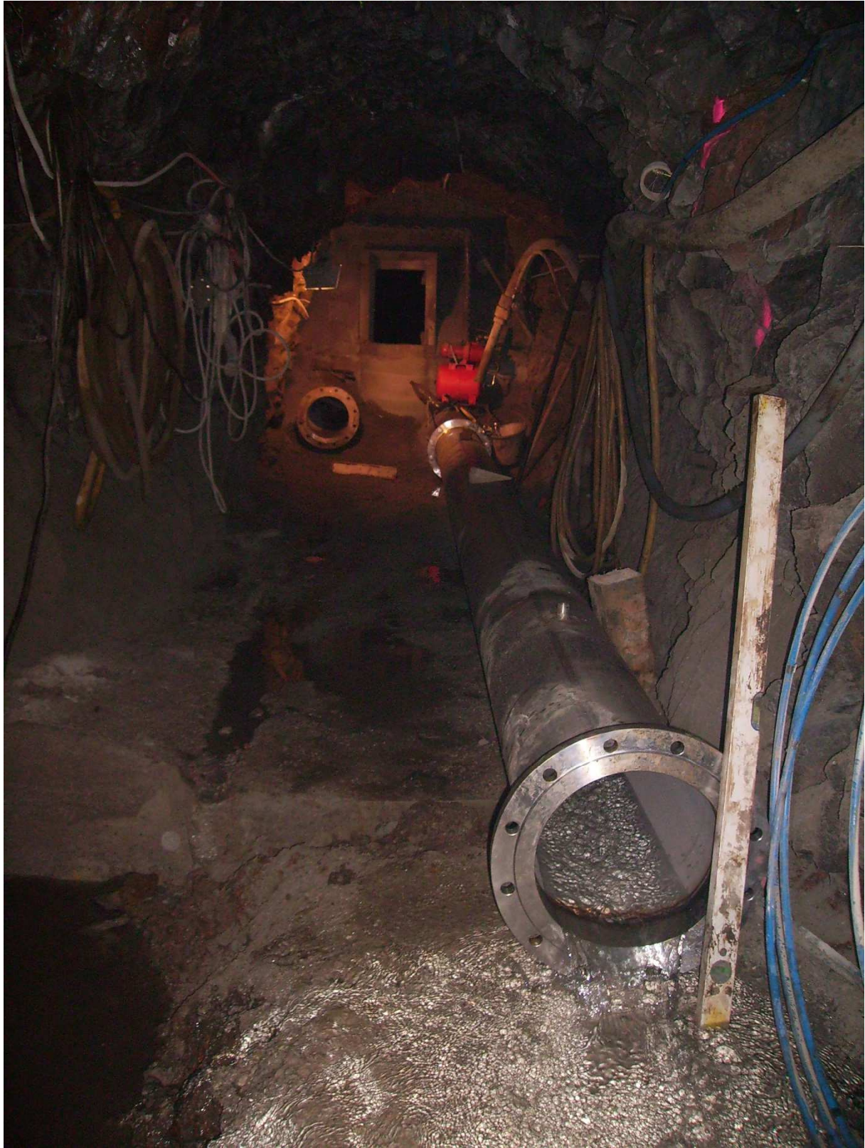
Einbau der Betonplombe nach der Überschwemmung 2005 Bild entnommen aus dem Archiv der Gemeinde Morsbach
