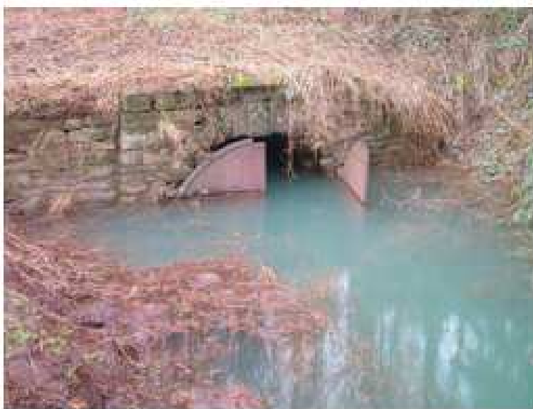
Ansicht des gleichen Stollenmundlochs der Grube Magdalena nach dem schwallartigen Wasseraustritt im Januar 2005. Das Wasser stand fast bis zum Schlussstein, der mit den Bergbausymbolen „Hammer und Schlägel“ und der Jahreszahl 1890 versehen ist. Fotos: C. u. H.-G. Buchen
