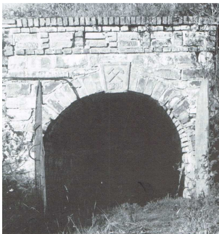
Das Stollenmundloch des Tiefen Magdalena Stollens bei Morsbach. Auf dem Gedenkstein unter den Hammer und Schlägel befindet sich die Jahreszahl 1890. Bild entnommen aus Morsbach – Chronik einer Oberbergischen Gemeinde
